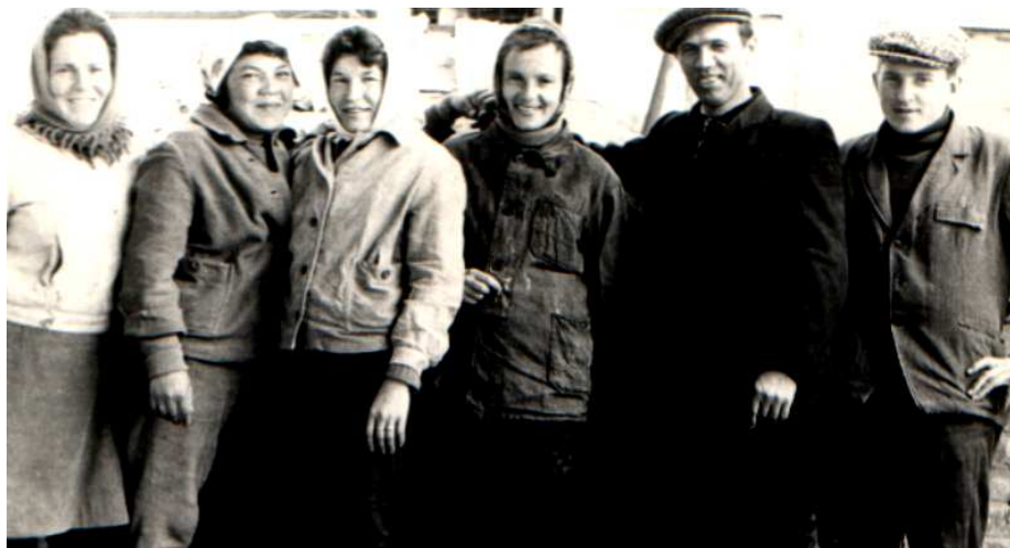
Бригада Радаева на строительстве котельной.
